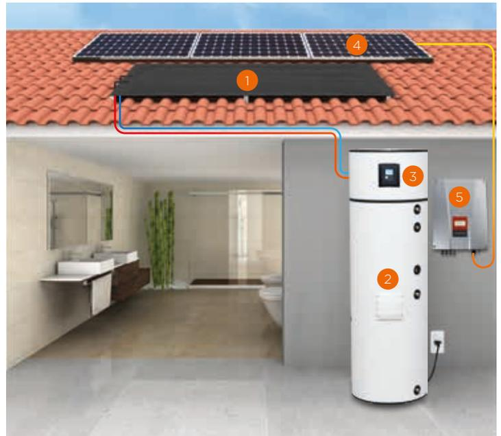
1. Pannello Solare Termodinamico. 2. Scaldabagno. 3. Blocco Termodinamico. 4. Pannelli Fotovoltaici. 5. Invertitore
